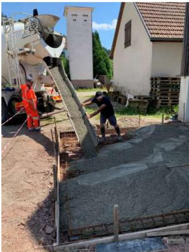
Création d'une dalle en béton pour faciliter l'accès au silo de la chaufferie bois par l'entreprise MG Terrassement
