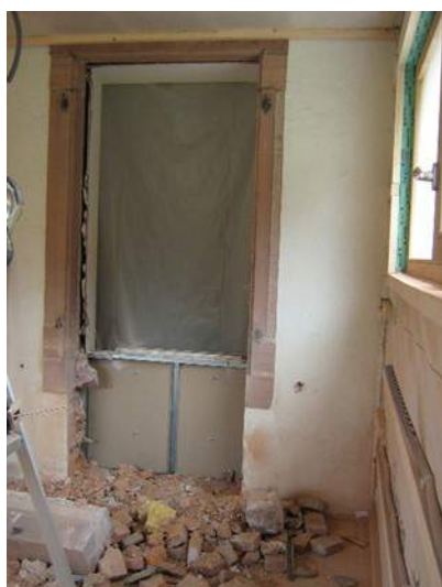
Ouverture de la fenêtre entre l'ancien bâtiment et l'extension, pose du placoplâtre
