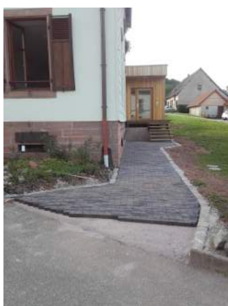
Création d'une allée en pavé par Sébastien, agent communal, pavés mis à disposition par l'Entreprise Altan
