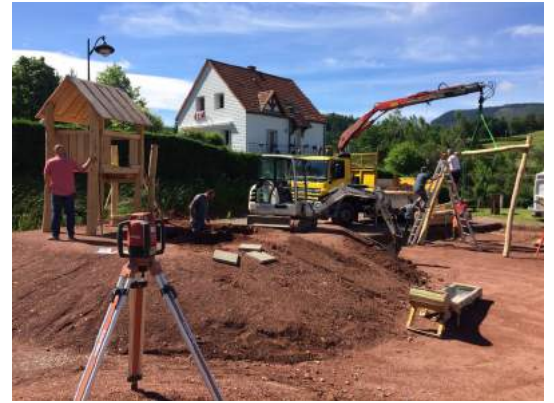
et installation des jeux
