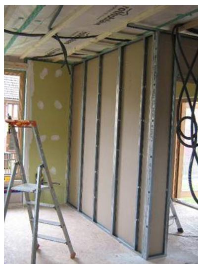
Ouverture de la fenêtre entre l'ancien bâtiment et l'extension, pose du placoplâtre
